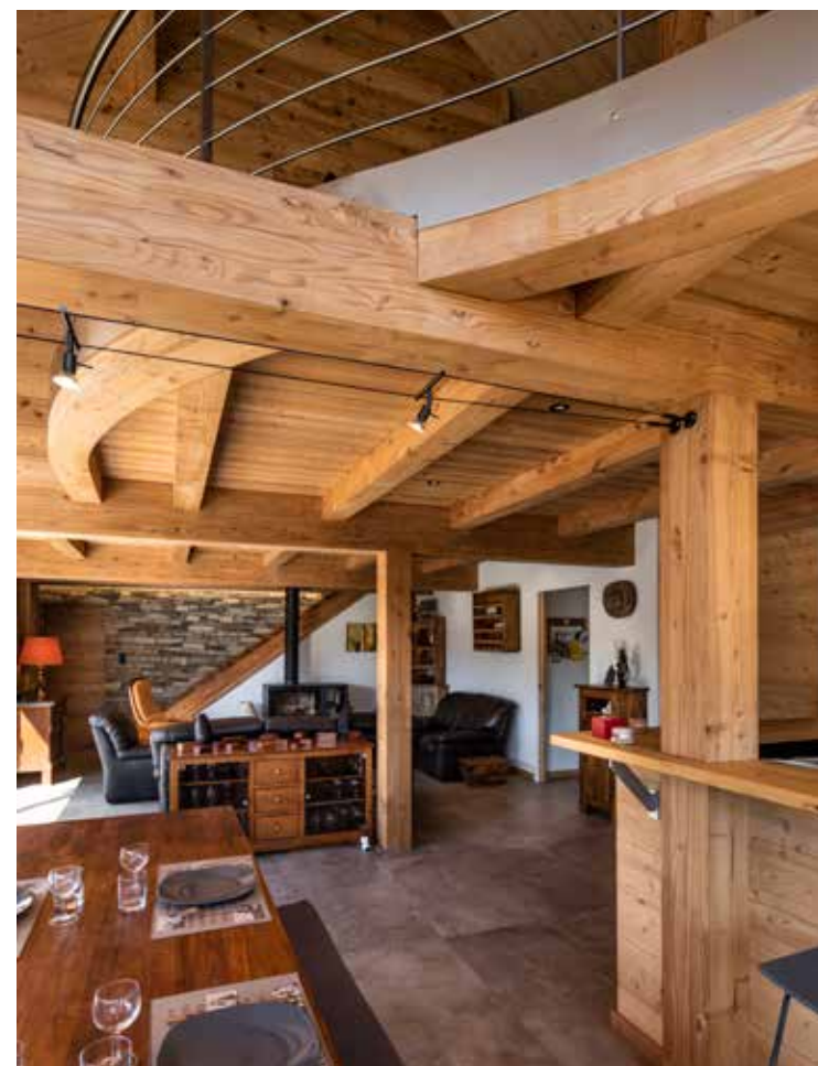
De belles poutres cintrées et des gardes-corps métalliques (Label Métal) identifient la mezzanine.
